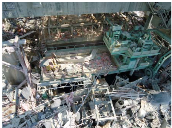
写真4 第4号機使用済燃料プール周辺の状況 (平成23年7月15日撮影)
