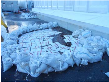
土のう設置状況
