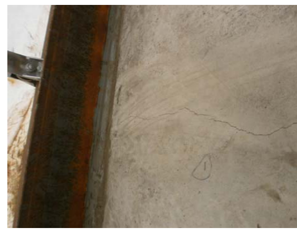
RO3ジャバラハウス床面(別途補修予定)
