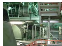
非常用ディーゼル発電機6A ・機器には外観上異常なし ・待機中
