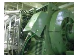
非常用ディーゼル発電機(HPCS) ・機器には外観上異常なし
