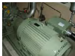
燃料プール冷却浄化系ポンプ ・機器には外観上異常なし
