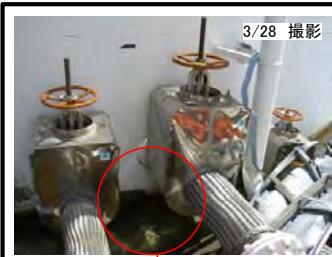
タンク下部に座屈による歪みが発生
