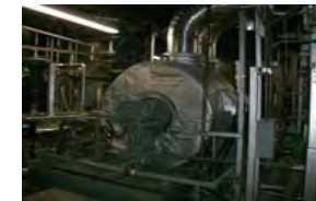
電動駆動原子炉給水ポンプ ・機器には外観上異常なし
