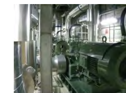
原子炉建屋補機冷却系ポンプ ・機器には外観上異常なし
