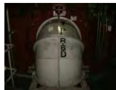
原子炉再循環系ライザー管 ・機器には外観上異常なし
