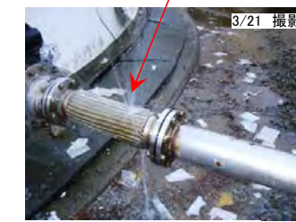
地震後漏洩が発生し、タンク出口元弁閉後の状況
