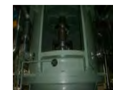
低圧炉心スプレイ系ポンプ ・機器には外観上異常なし
