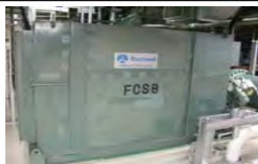
可燃性ガス濃度制御系 ・機器には外観上異常なし
