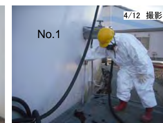
タンク下部に座屈による歪みが発生
