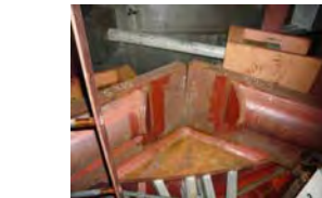
スタビライザー(RPV側) ・機器には外観上異常なし
