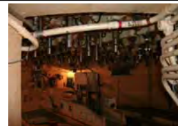
ペDESTル内 ・機器には外観上異常なし
