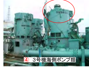
3号機残留熱除去系海水ポンプ(D)モーターカバー無し
