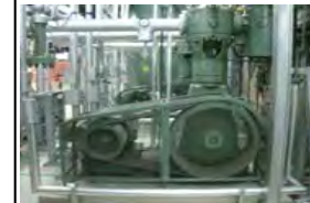
計装用空気圧縮機 ・機器には外観上異常なし (A)待機中 (B)運転中
