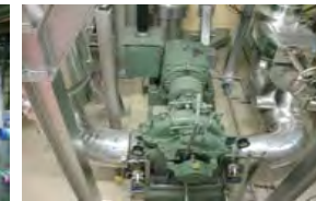
タービン建屋補機冷却系ポンプ ・機器には外観上異常なし (A)電源水没により使用不可 (B)運転中 (C)待機中
