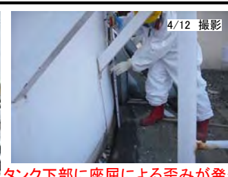
タンク下部に座屈による歪みが発生
