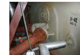
スタビライザー(PCV側) ・機器には外観上異常なし
