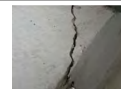
給水加熱器 ・給水加熱器5Bの固定脚基礎に若干の割れがあるが、機器にはその他外観上異常なし
