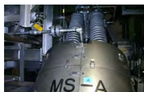
主蒸気隔離弁 ・機器には外観上異常なし
