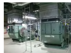
非常用ガス処理系 ・機器には外観上異常なし A/B交互運転中
