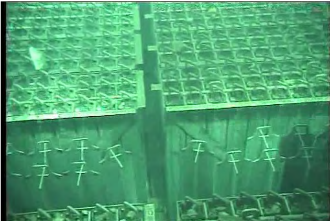
図 8 4号機のプール水中の状況 (その3)
