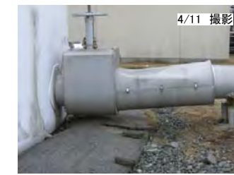
地震後漏洩が発生し、タンク出口元弁閉後の状況
