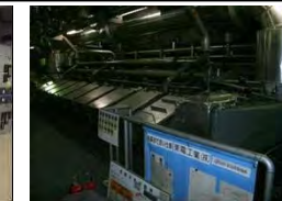
非常用ディーゼル発電機5A,5B ・機器には外観上異常なし
