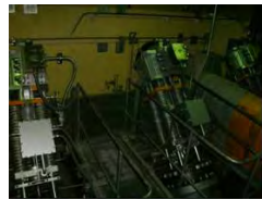
主蒸気隔離弁 ・機器には外観上異常なし
