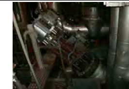
主蒸気隔離弁 ・機器には外観上異常なし
