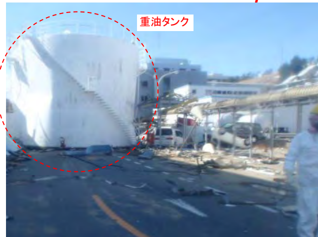
道路は大きな損傷はないが、津波で流された重油タンクが道路を塞ぎ、通り抜け不可能。 3/17撮影
