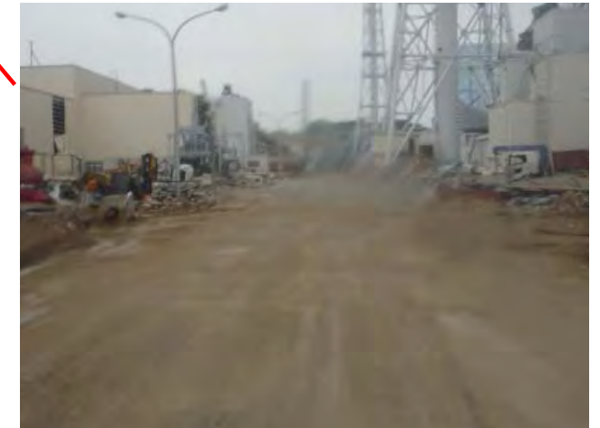
1~4号機西側道路は特に異常なし。1,3,4号機R/B損壊時には瓦礫散乱があった。 3/20撮影
