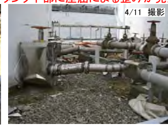
タンク下部に座屈による歪みが発生
