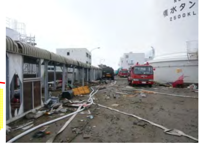
道路には特に異常がないが、瓦礫が散乱。 3/16撮影
