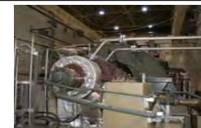
タービン駆動原子炉給水ポンプ ・機器には外観上異常なし
