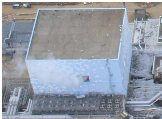
2号機ブローアウトパネルの開放状況
