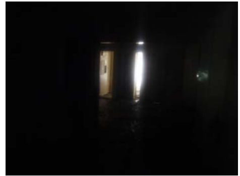
サービス建屋入口の建屋内の状況
