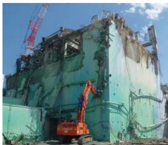
3号機瓦礫撤去作業
