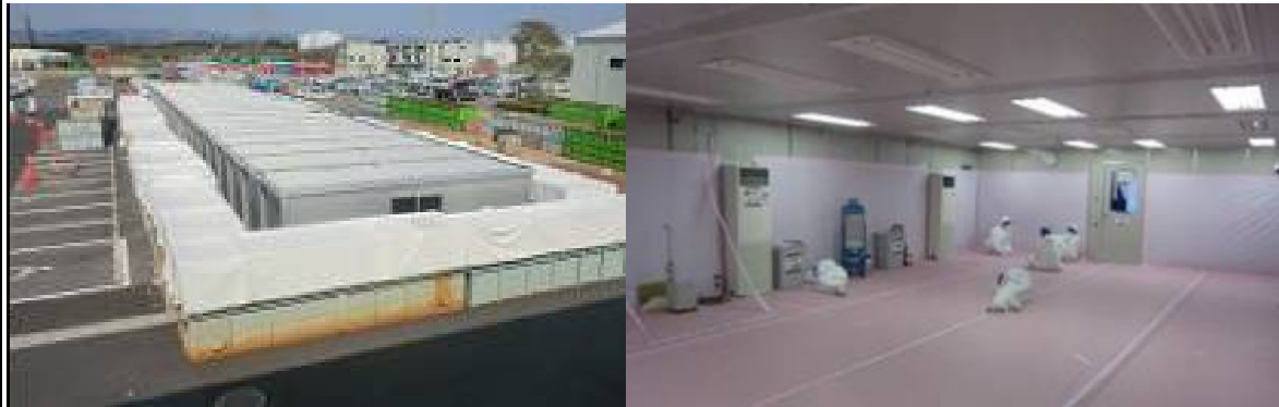
現場休憩施設外観(左)と内観(右)
