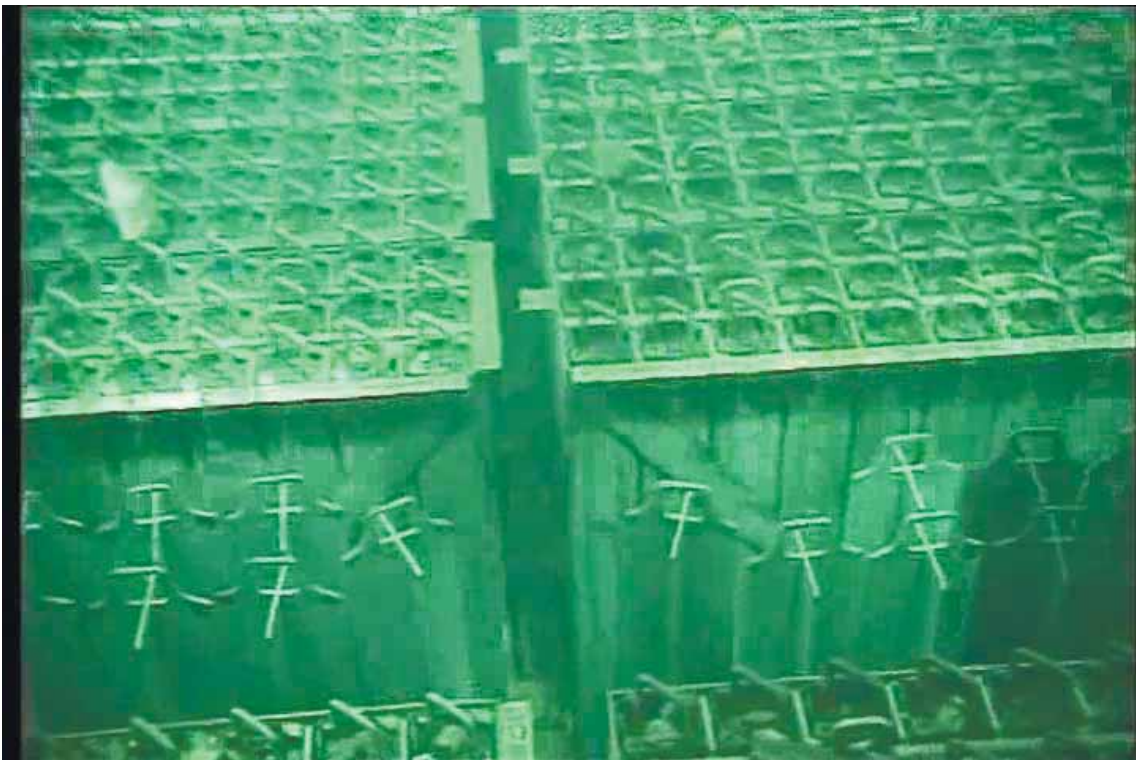
図13-5-8 4号機のプール水中の状況（その3）
