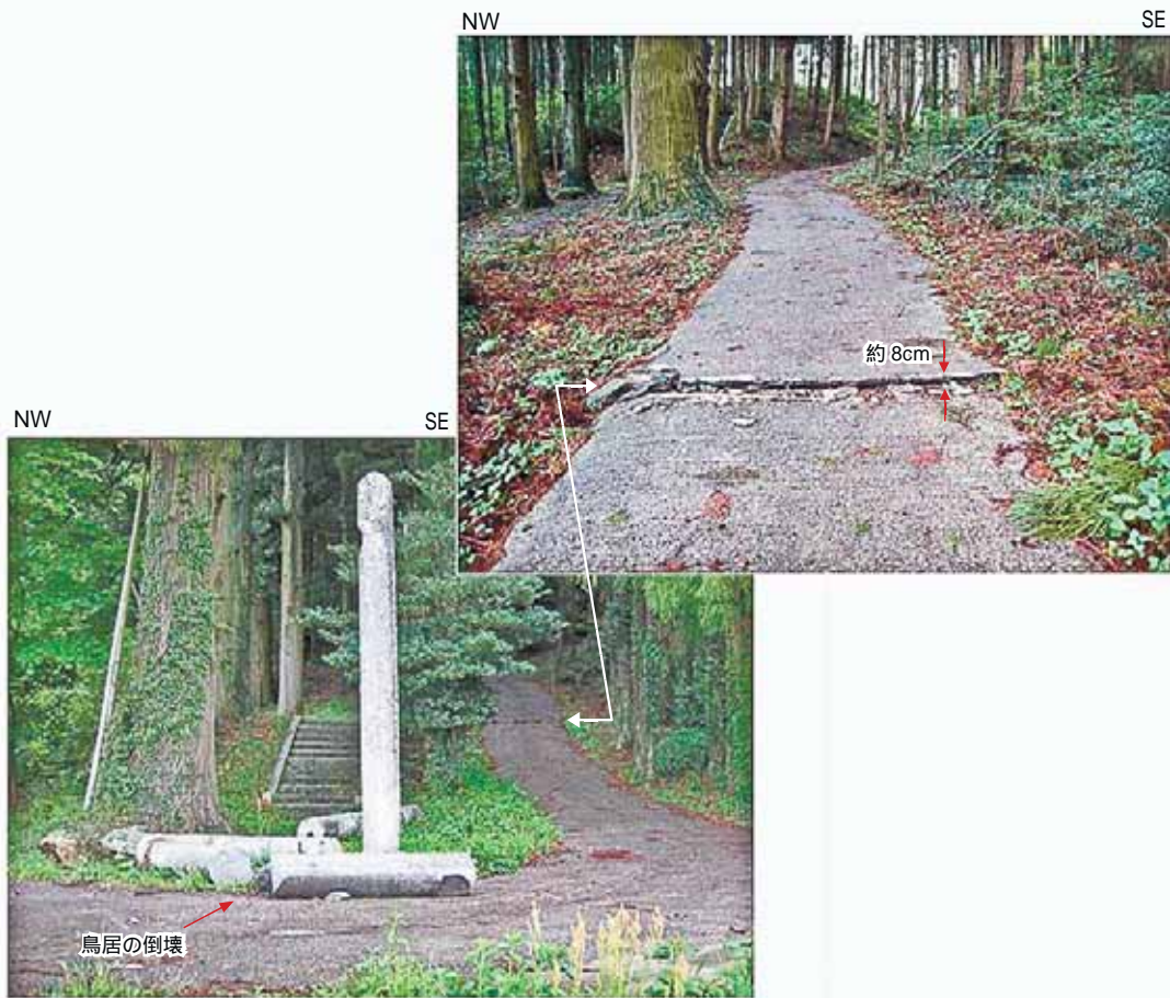
Loc.3j 路面に約 8cm 南西落ちの上下変位が認められる。
