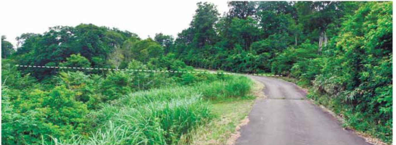
Loc.t141 野々海池 逆向き崖地形を横断する道路面上に変状は認められない。
