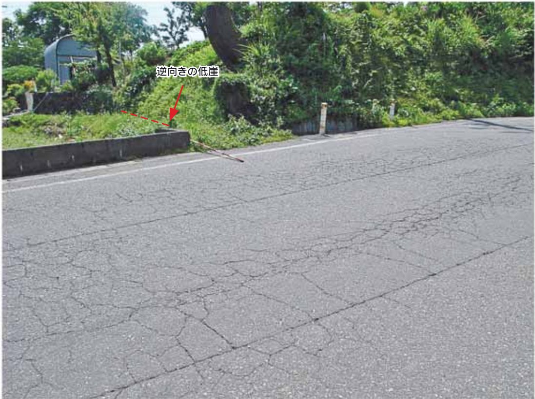
Loc. t97 新潟県中魚沼郡津南町大字下船渡卯ノ木 逆向きの低崖を横断する道路に変位・変状は認められない。
