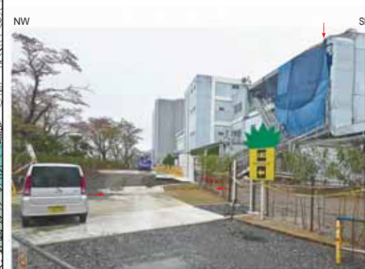
Loc.Y-22 M1面上に出現した地震断層。南西落ち約80cmの上下変位が認められる。地震発生前の空中写真によると同面に変位地形は認められない。
