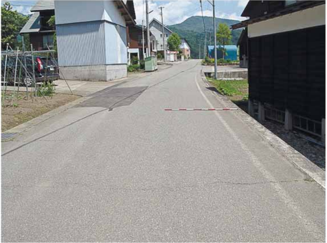
Loc. t87 新潟県津南町亀岡 撓曲崖の西方延長部 道路面には変位・変状は認められない。
