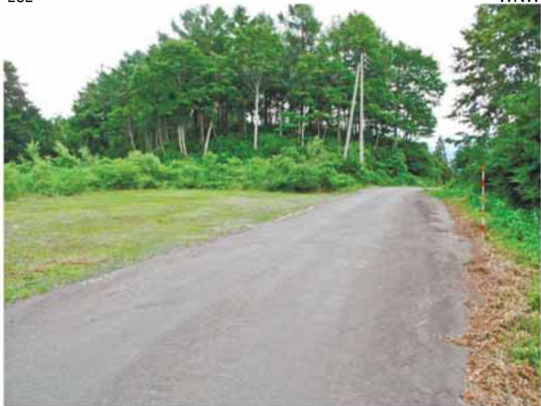
Loc.t139 平滝北 逆向き崖地形を横断する道路面上に変状は認められない .
