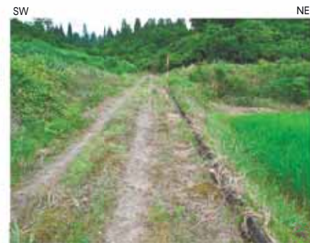
r地点: 未舗装道路と側溝には変状は認められない。
