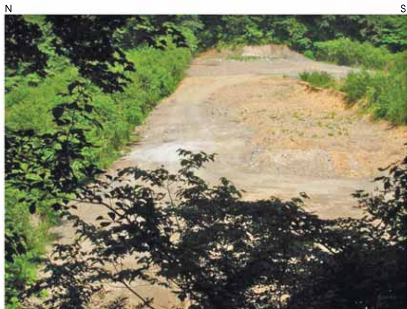
Loc.K102 新八釜鉦山敷地内の堤に地震時における地変は認められない。
