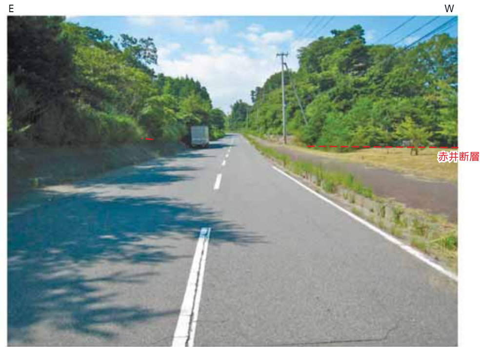
Loc.a-2, いわき市平赤井 赤井断層通過地点の路面に変状は認められない。
