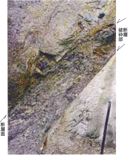
同左拡大。断層面破砕部は固結し、断層面は癒着している。
