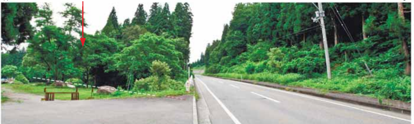
Loc. t98 新潟県津南町大字下船渡卯ノ木 急崖基部付近の状況 断層が示される位置付近の道路に変位・変状は認められない。
