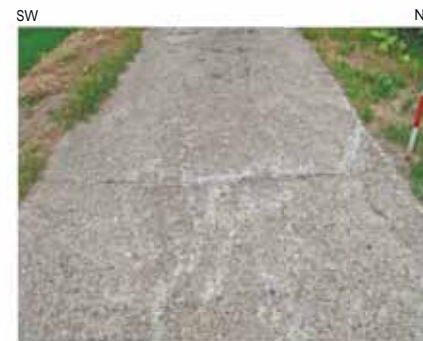
i地点: 農道舗装面上に認められるSW-NE走行のクラック。南側が数cm低下。
