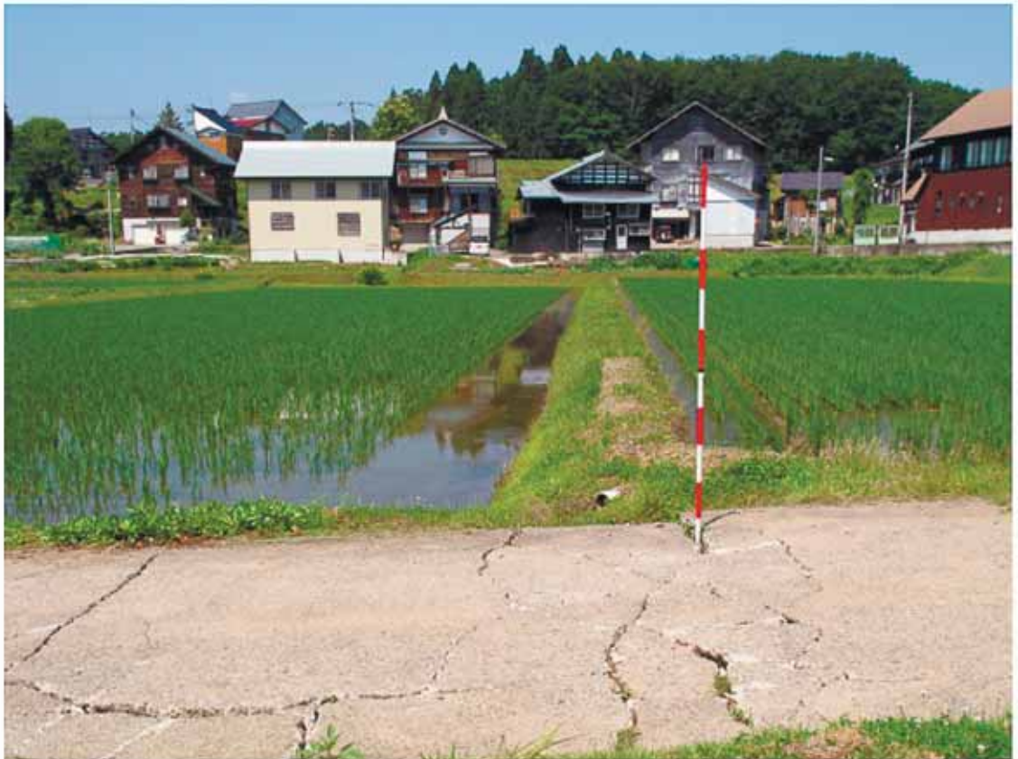
Loc. t01西側の畔に変状は認められない。
