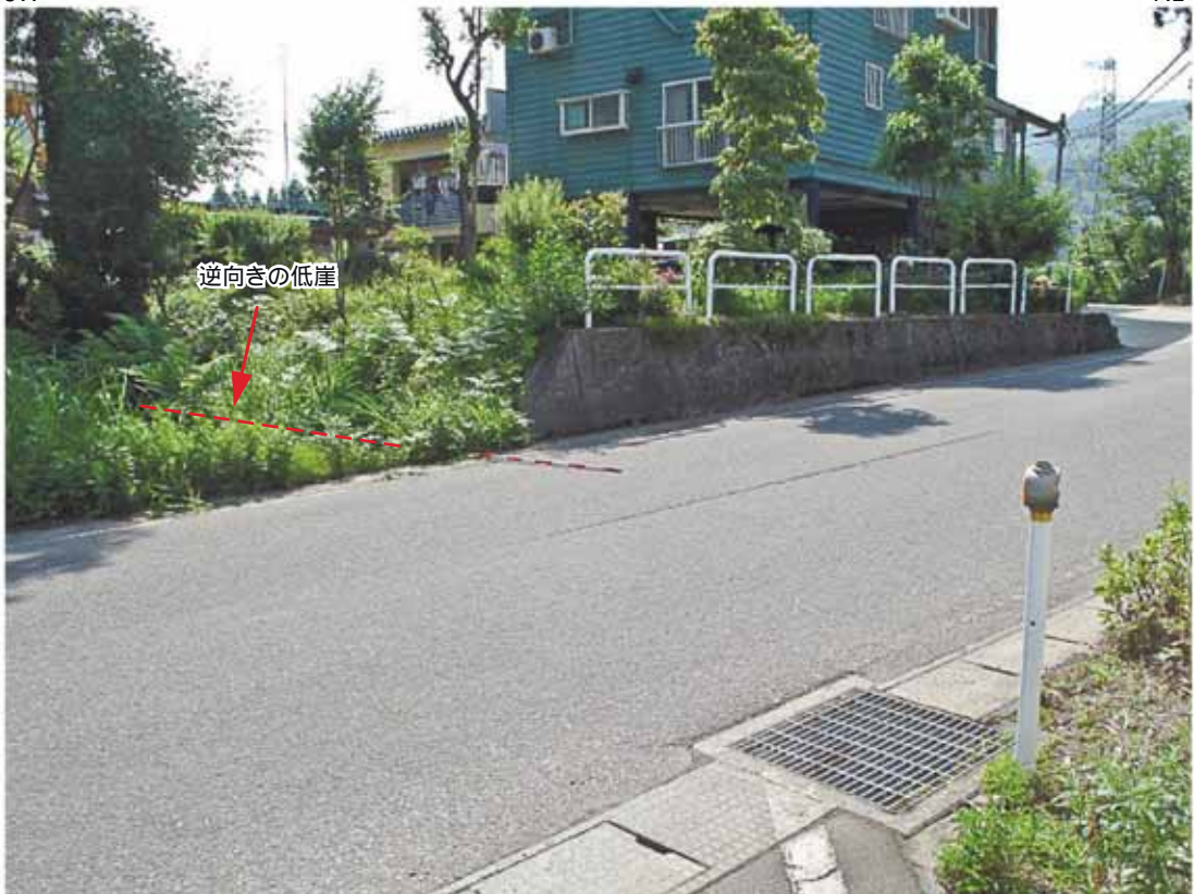
Loc. t103 新潟県十日町市干溝 逆向きの低崖を横断する道路に変位・変状は認められない。
