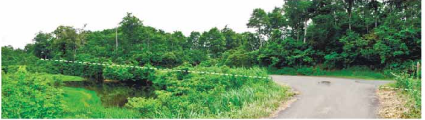
Loc.t140 野々海池 逆向き崖地形を横断する道路面上に変状は認められない。
