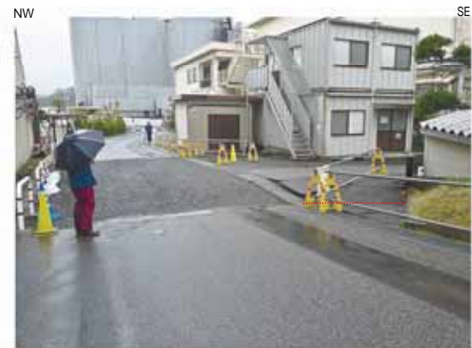
Loc.Y-23 M1面上に出現した地震断層。南西落ち約70cmの上下変位が認められる。地震発生前の空中写真によると同面に変位地形は認められない。
