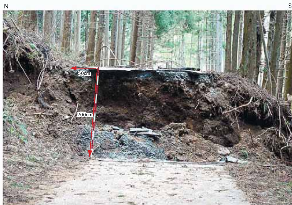
Loc.Id-20 道路面に出現した地震断層。西落ち約 200cm の上下変位，左ずれ約 50cm の水平変位が認められる。
