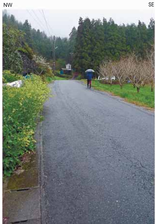
Loc.Y-10(いわき市遠野町深山田仲内) 湯ノ岳断層通過地点付近において変状は認められない。
