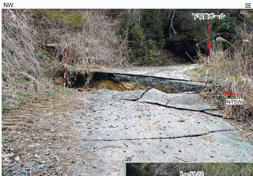
Loc.Id-22 道路面に出現した地震断層。 西落ち約 70cm の上下変位が認められる。
