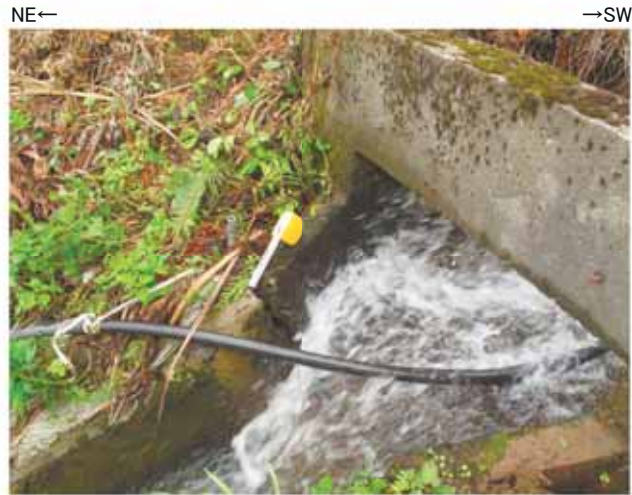
a地点: 南側クラックの南南西延長部に位置する用水路のコンクリート破断面。破断面は新鮮ではなく、今回の地震以前に重力性のすべりにより生じた可能性が高い。
