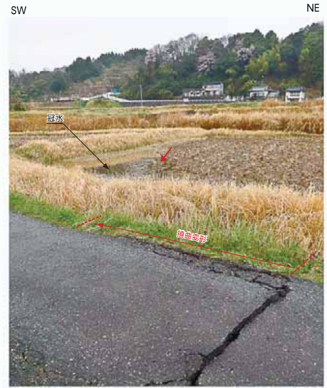
同左 低下側の水田は冠水している。「↓」地点まで撓曲，クラックが連続する。
