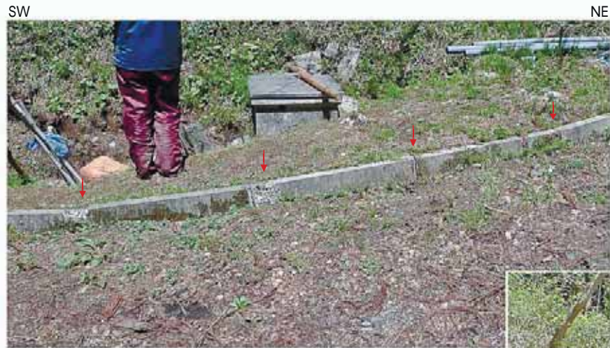
撓曲部拡大 U字溝の接合部が破損している。
