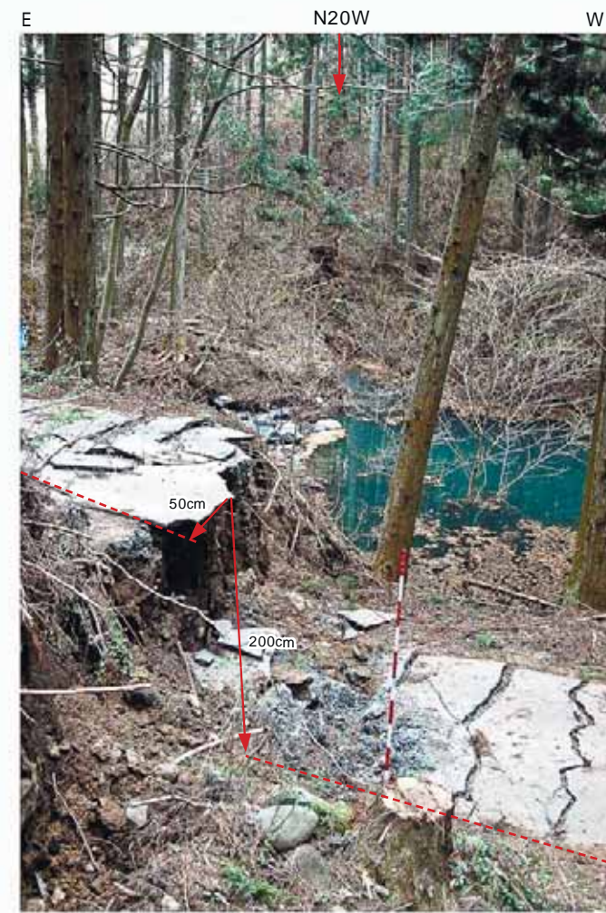
同左及びその南側の谷 谷に地震断層が出現し，低下側（上流側）に閉塞池が形成されている。
