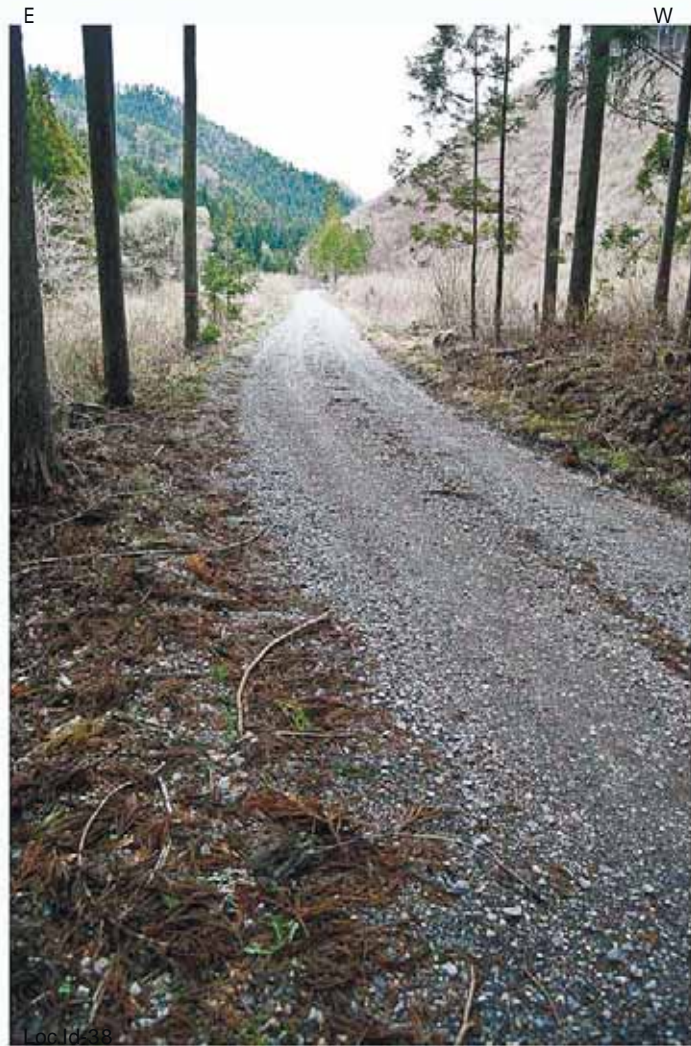
地震断層延長部の林道路面に変状は認められない。
