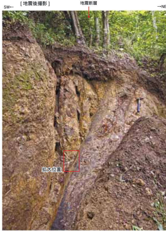
Loc.K611 地震時に低下した西上盤側の地表付近には開口クラックが発達する。
