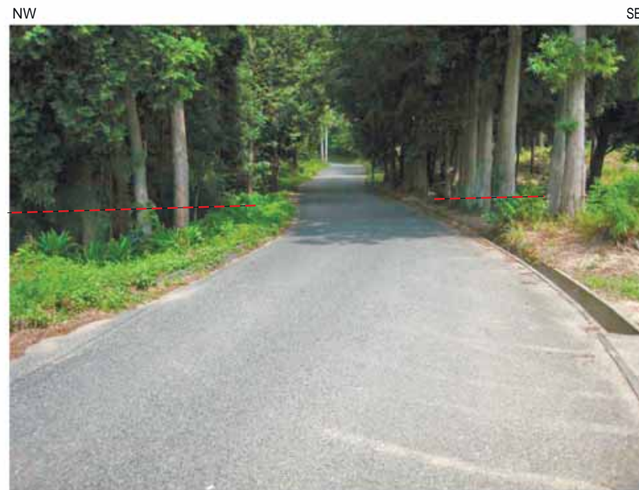
Loc.O-2,いわき市大平 大倉断層群のうち,南の断層通過地点の路面に変状は認められない。
