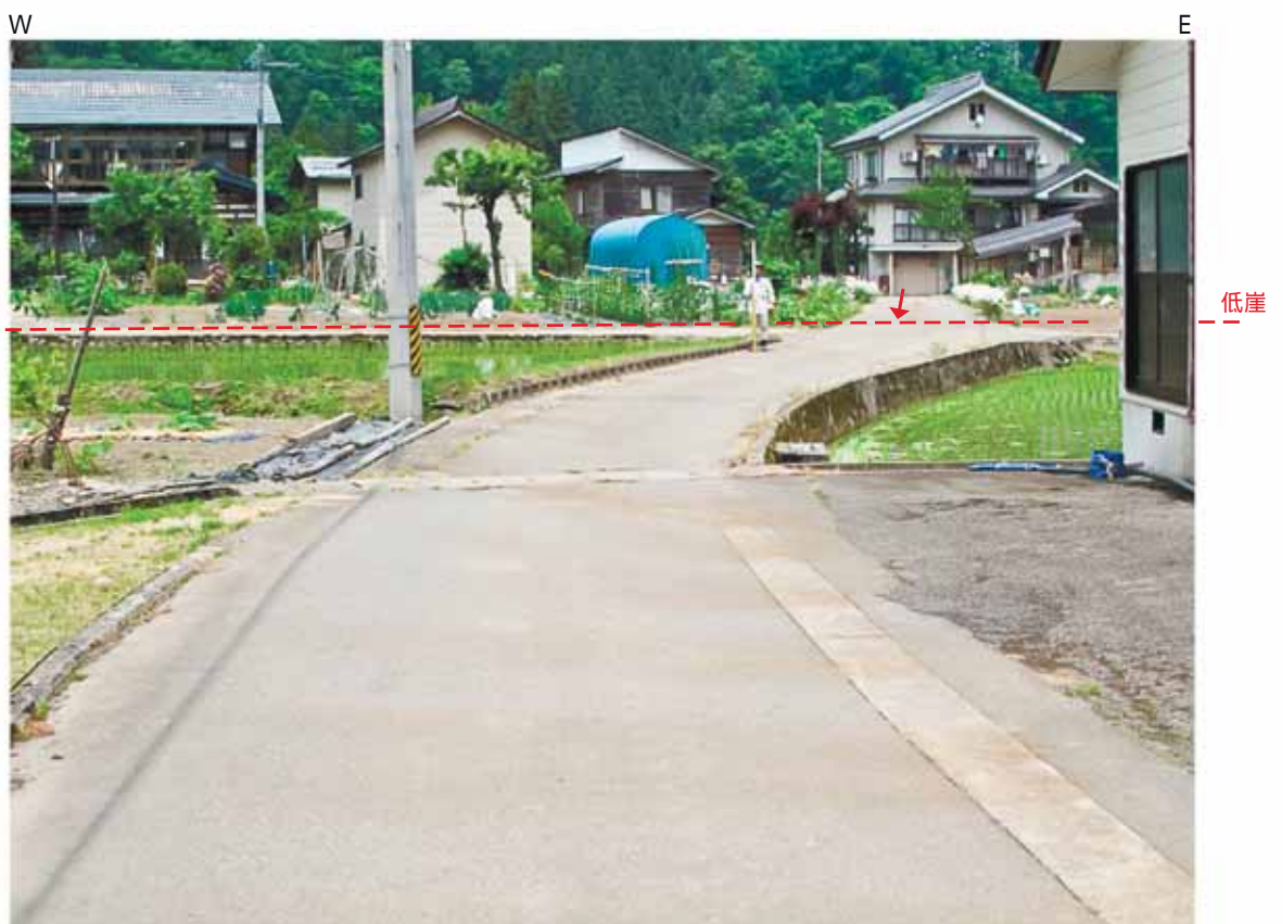
Loc. t08 新潟県津南町大字芦ヶ崎小下里 低崖の東方延長上の道路面に変位・変状は認められない
