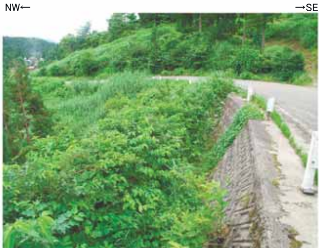
b地点: 南側クラックの南南西延長部に位置する道路擁壁面の状況変状は認められない。
