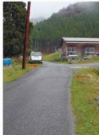
地震後に道路に直交方向のクラック (→) が認められ、路面は若干撓曲状を示す
