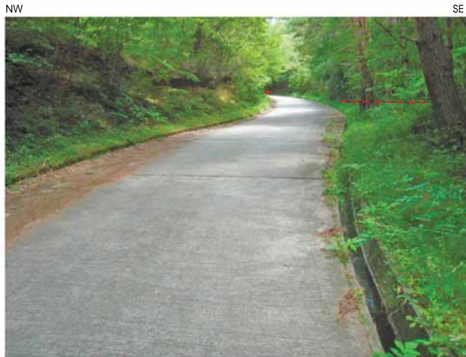
Loc.O-1,いわき市猿倉 大倉断層群のうち,北の断層通過地点の路面に変状は認められない。
