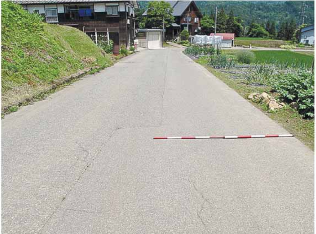
Loc. t88 新潟県津南町亀岡 撓曲崖の西方延長部 道路面には変位・変状は認められない。
