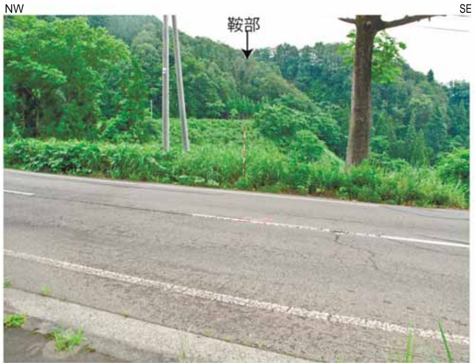
Loc.t131,辰ノ口 舟繋川下流 LDリニアメント(鞍部)の延長部を横断する道路は、不明瞭なクラックが認められるものの、明瞭な地変は認められない。
