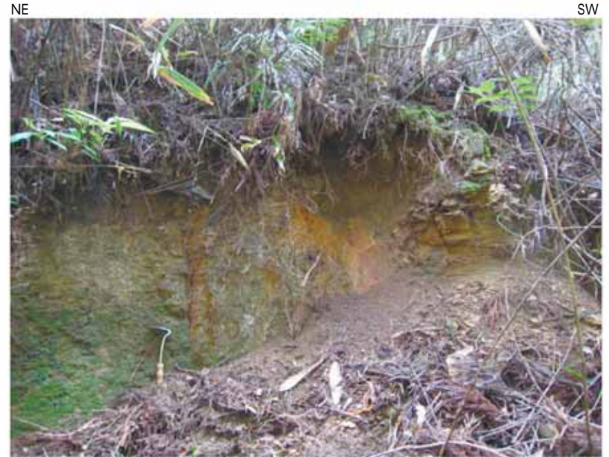
Loc.Iw104 地震時における変位は認められない。
