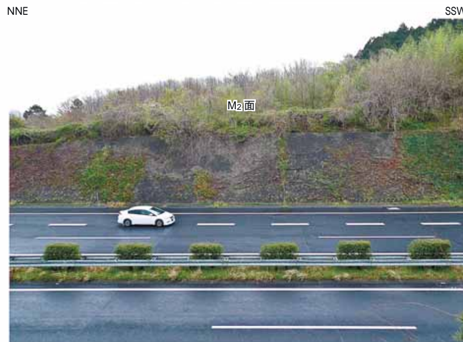
Loc.Y-19(いわき市常磐藤原町田場坂) 湯ノ岳断層通過位置付近において、常磐自動車道の法面などに変状は認められない。
