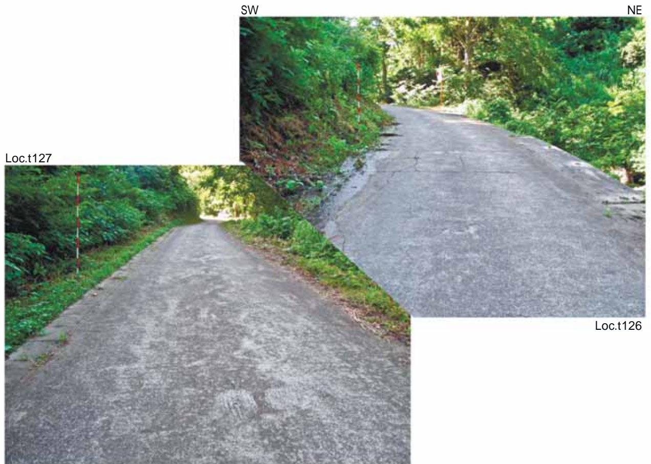
Loc.t126, Loc.t127; 外丸 田沢川上流 LDリニアメント(鞍部)の延長部を横断する道路は、不明瞭なクラックが認められるものの、明瞭な地変は認められない。
