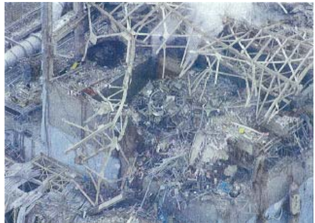
図-2.3 5階北西側の床スラブの状況
