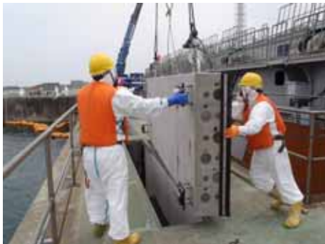
角落としの設置
