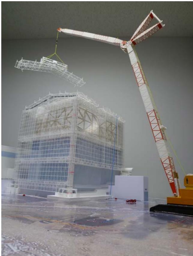
写真2 福島第一原子力発電所1号機原子炉建屋カバー施工検討模型
