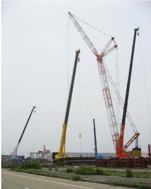
写真1 クローラクレーンを用いた原子炉建屋カバーユニットの仮組み（小名浜港）
