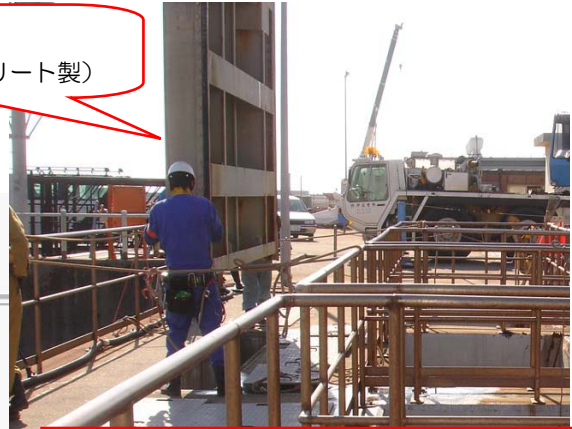
角落とし設置状況 （1～4号機にて今後実施）
