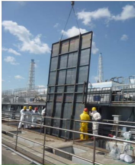
鉄板設置[既実施]（2号機） （4/15完了）
