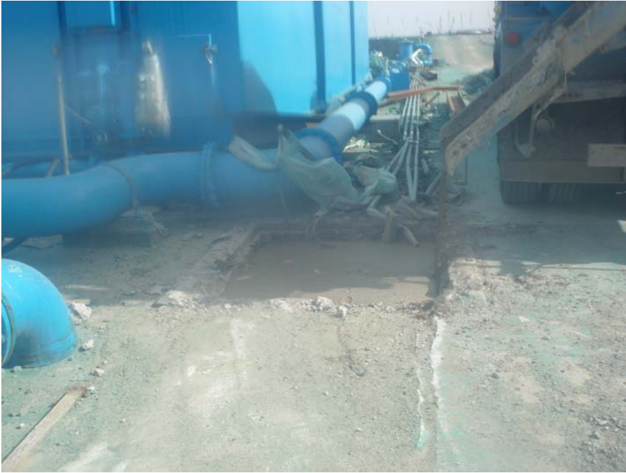
コンクリート打設の事例[No.84]
