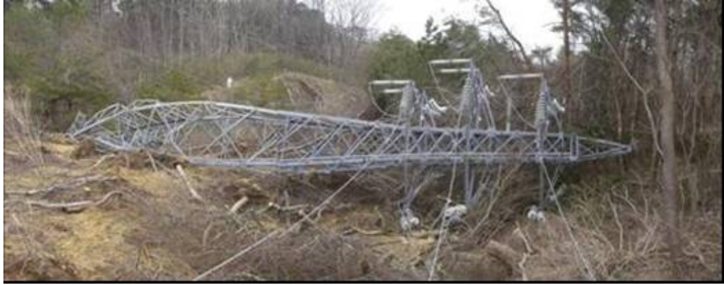
図2 鉄塔全体の写真
