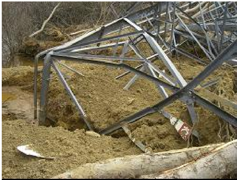
図3 鉄塔脚部の写真
