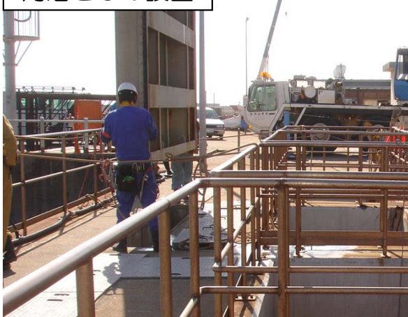
角落としの設置
