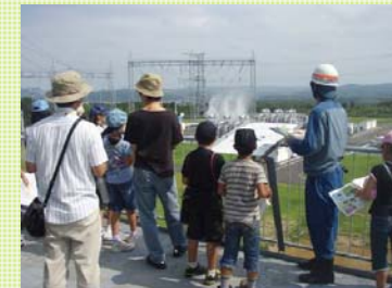
〈新木更津変電所〉
