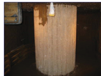
— 杭頭状況 (ST-3) —
