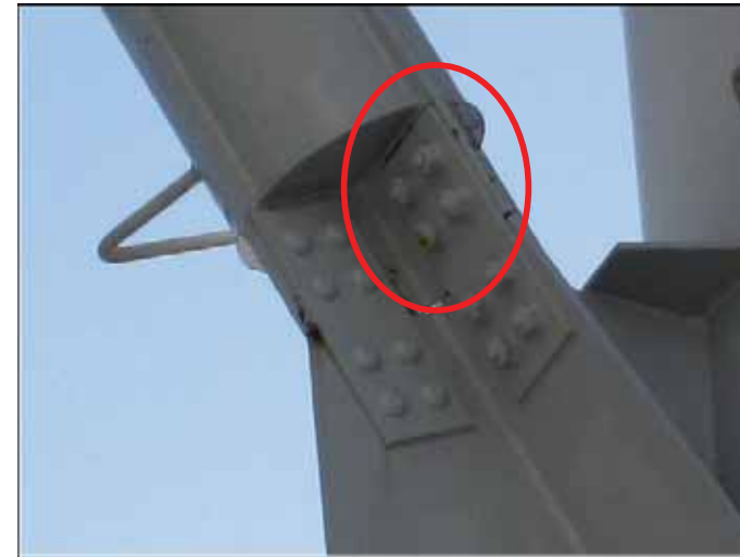
① 斜材接合部 塗膜剥離
