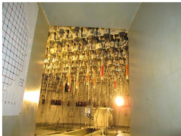
制御棒駆動機構(185台)
