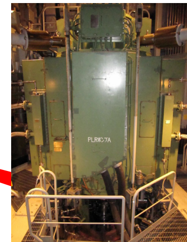
原子炉再循環ポンプ 電動機(2台)
