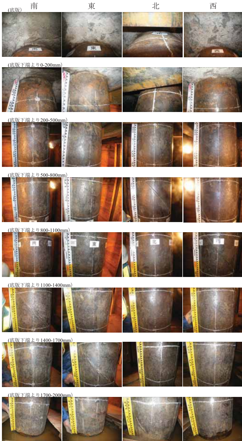
参写真-14.1 鋼管杭の表面状態
