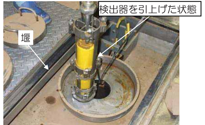
主蒸気管放射線モニタ検出器C外形図
