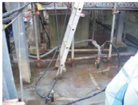
基礎に穴をあけ、モルタルを注入している
