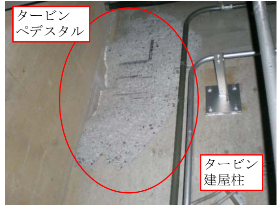
(2)剥落状況写真(No.④-4)
