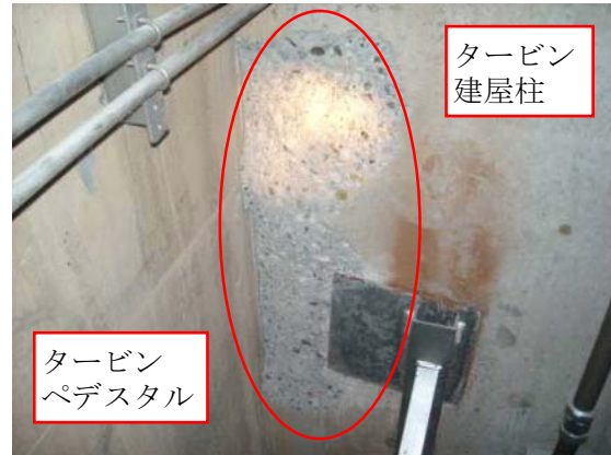
(2)剥落状況写真(No.④-3)
