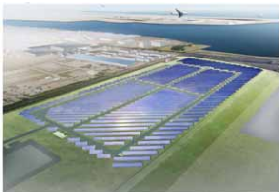
(仮称)浮島太陽光発電所
