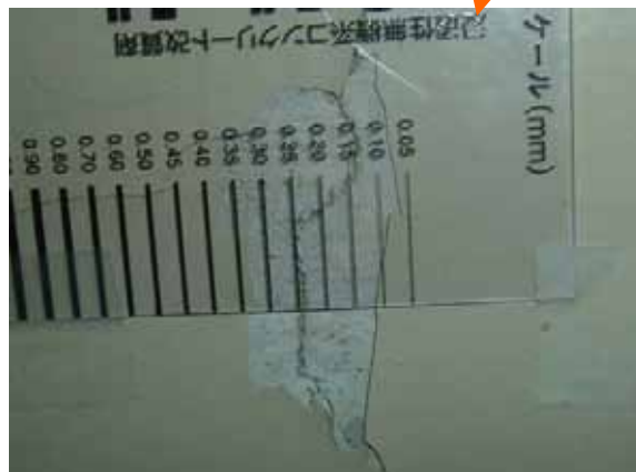
南側側面ひび割れ状況
