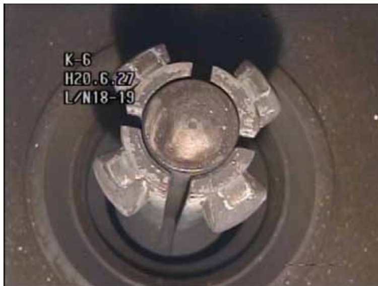
FMCRD側カップリング部
