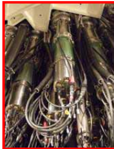
制御棒駆動機構(205台)
