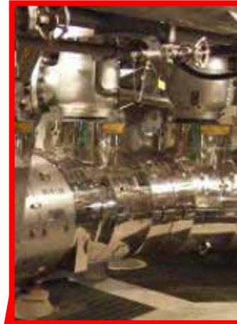
主蒸気逃し 安全弁(18台)
