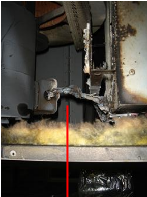
ケーブルの外観目視
