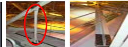
つなぎばりの補強 下弦水平ブレースの補強
