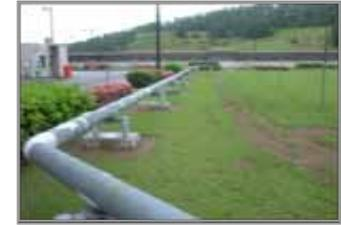
埋設消火配管の地上化
