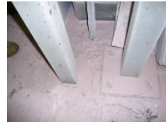
空調機電動機電源用床立上げ 電線管廻り焼損有り
