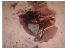
PT用スプレー缶による床 の汚れ
