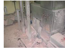
保管箱裏面にあたる場所 から空調機左側面に至る 場所まで熱による塗装の めくれ、煤の付着がある
