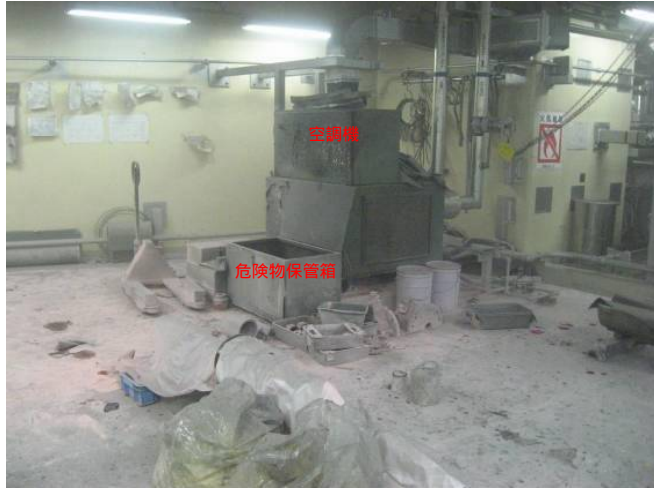
空調機電動機電源用床立上げ 電線管廻り焼損有り
