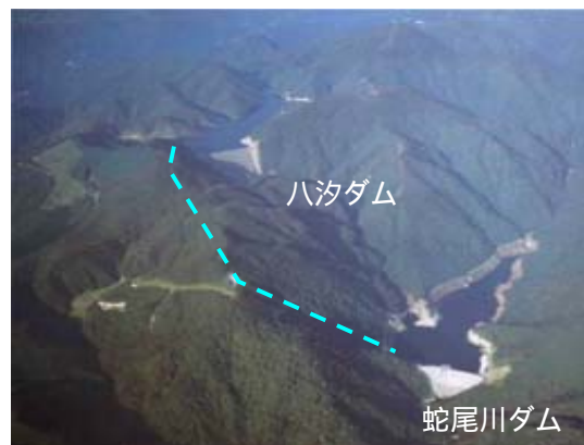
塩原発電所鳥瞰写真
