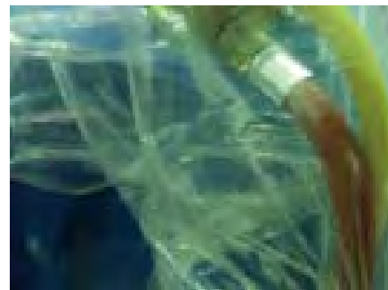
15分運転後のビニール養生内部状態
