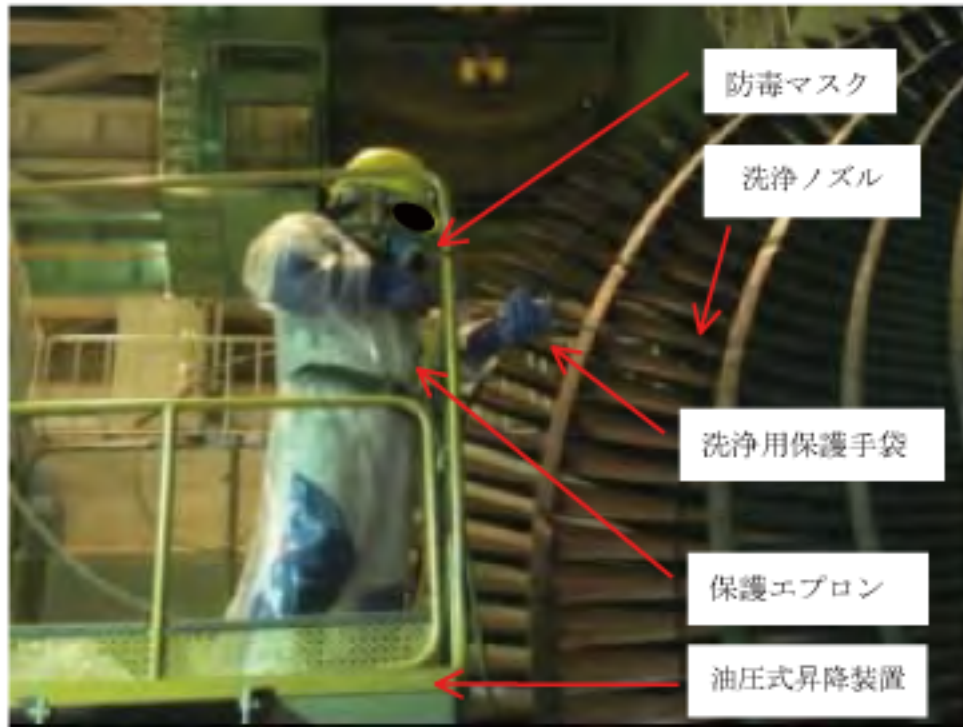
油圧式昇降装置上での洗浄作業風景
