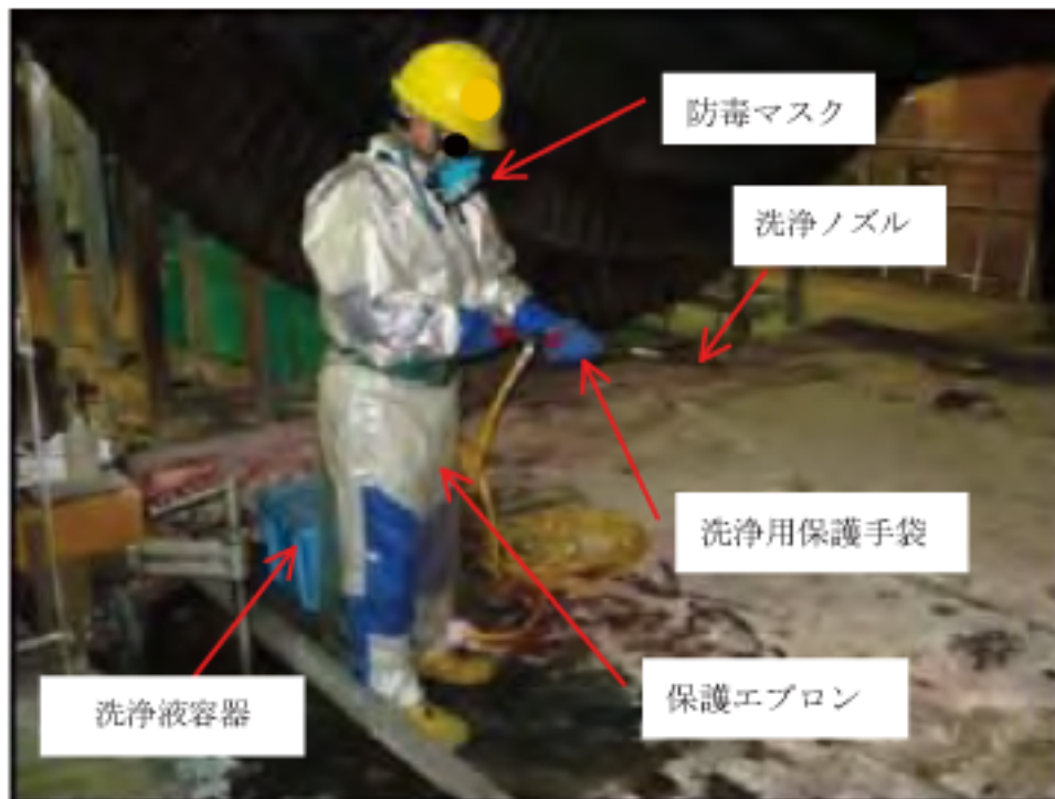
油圧式昇降装置下でのロータ下部の洗浄作業風景
