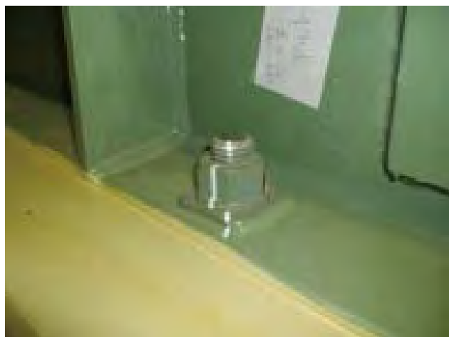
図一5 非常用ガス処理系フィルタ装置の目視点検状況（参考）
