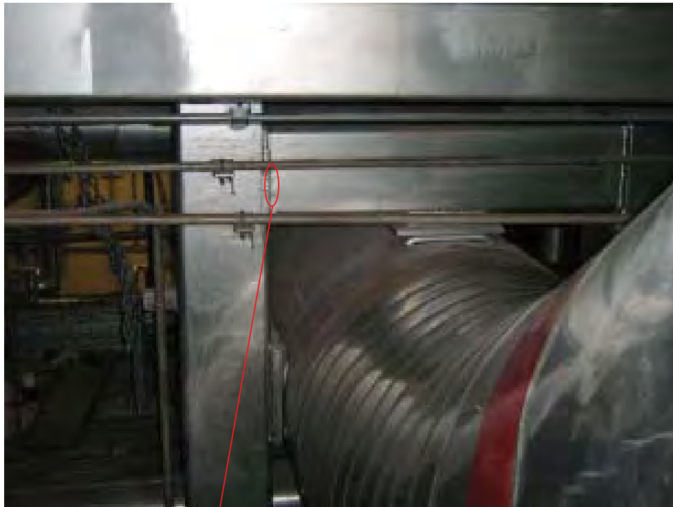
ひび割れ位置
