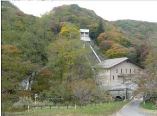
明治 15 年に竣工した<sup>あさかそすい</sup>安積疏水の沼上滝の落差を利用し、郡山絹糸紡績会社によって明治 32 年 6 月に運転開始された。当時は、出力 300kW、電圧 1 万 1 千 V で 22km あまり離れた現在の郡山市に送電し、郡山市の産業発展の原動力となった。当社で 3 番目に古い水力発電所で、平成 11 年 6 月に百周年を迎えた。なお、現在の発電所建屋は昭和 61 年に建替えている。
