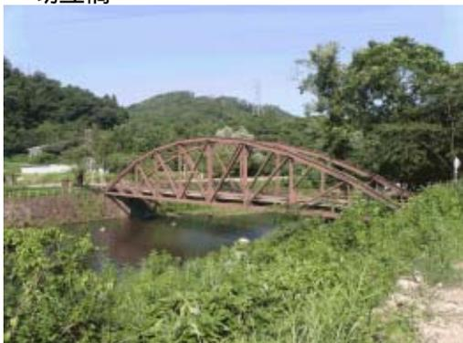
大正 10 年、「東京電灯株式会社（現在の東京電力株式会社）猪苗代第四発電所」の建設時に資材輸送用軌道を布設した際に架橋された。明治 23 年にドイツのハーコート社で製作され、九州鉄道（現在の J R 九州）で利用されていたものが、架け替えに伴い転用された。当初は、猪苗代第四発電所の建設に必要な資材運搬用の鉄道橋梁として使われていたが、現在では一般道の橋梁として利用されている。
