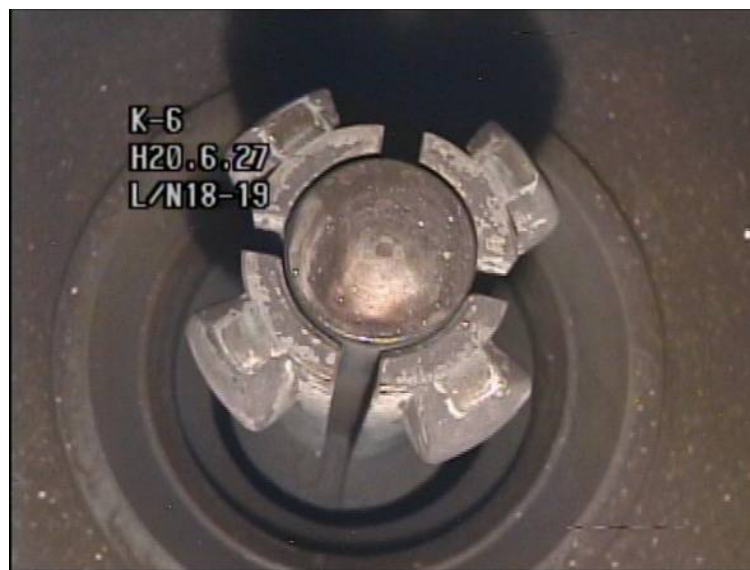
FMCRD側カップリング部
