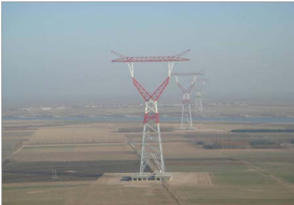
中国UHVパイロット送電線（黄河横断）
