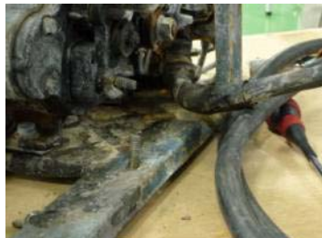
溶接パワーケーブル及び接続部 焼損程度は軽微
