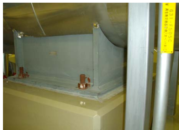
図一1 原子炉冷却材浄化系再生熱交換器の事象
