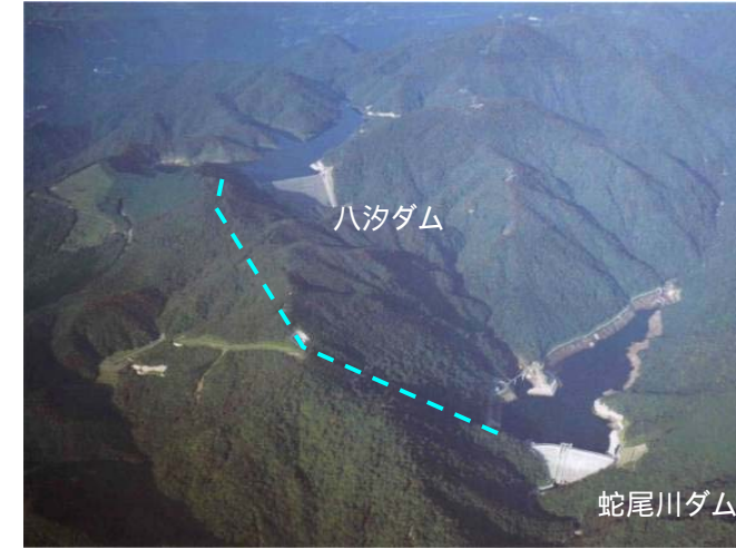
塩原発電所鳥瞰写真
