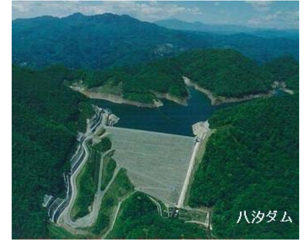
八汐ダム・調整池全景
