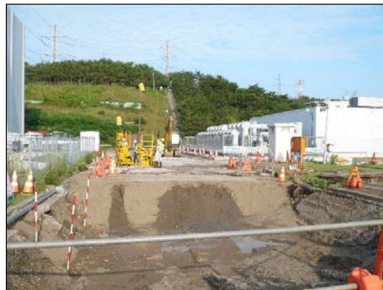
防災道路補強工事中 (現状)
