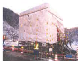
ボーリング足場
