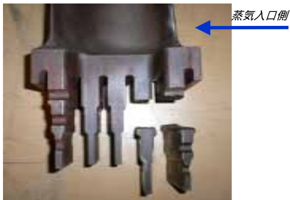
低圧タービン(C)第14段(タービン側)動翼フォーク部 損傷箇所(119枚目)(お知らせ済み)
