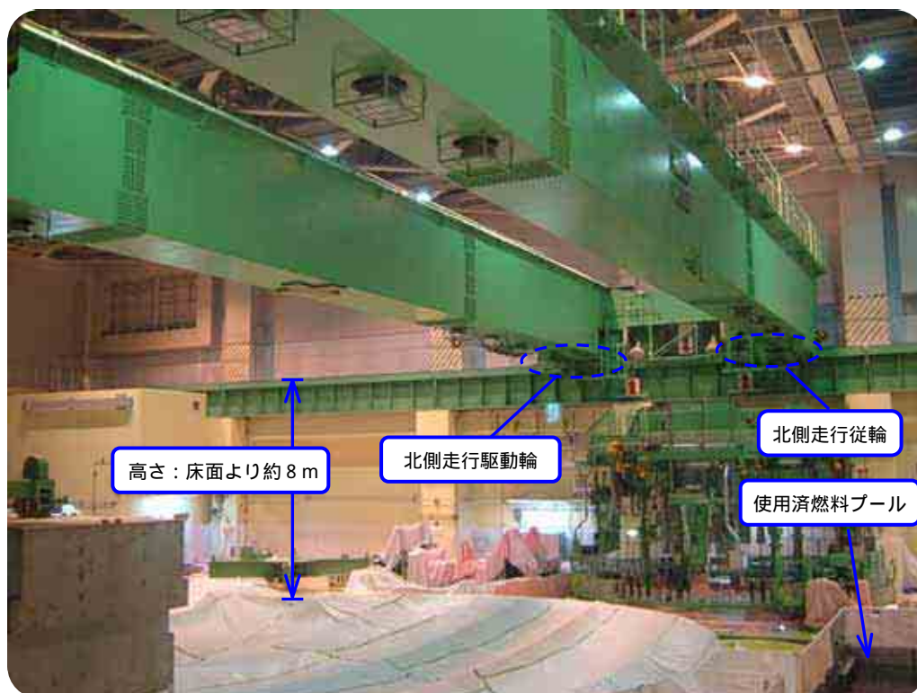
原子炉建屋天井クレーン全体写真
