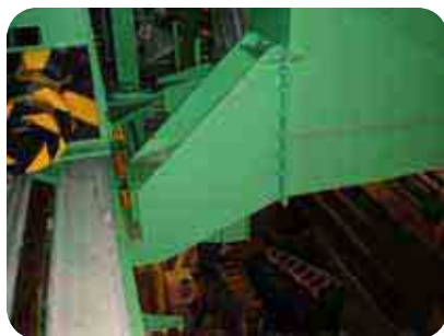
南東側脱線防止ラグ
