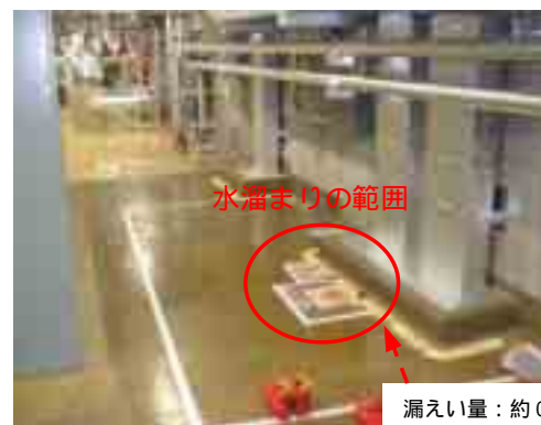
原子炉建屋3階 漏えい箇所（非管理区域）
