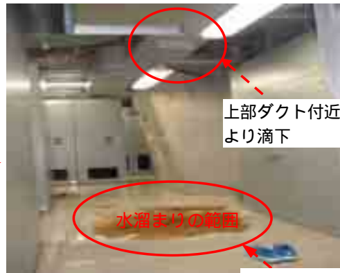
原子炉建屋中3階 漏えい箇所（非管理区域）
