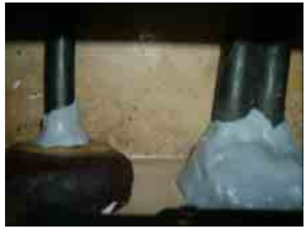
シール材補充状況 ( 2 )
