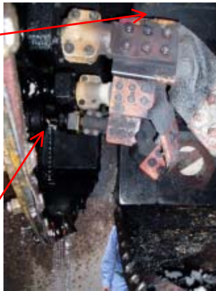
写真4 二次ブッシング碍管破損と漏油(下段)
