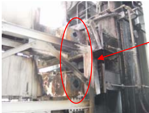
写真7 二次側接続母線部損傷状況(防火壁側)
