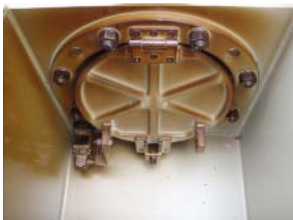
写真9, 10 放圧装置(安全ピンは破断し動作。放圧板にしわがあるが破れていない)
