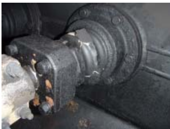
写真3 二次ブッシング碍管のひび割れ(容易に剥がれる) (上段V相)
