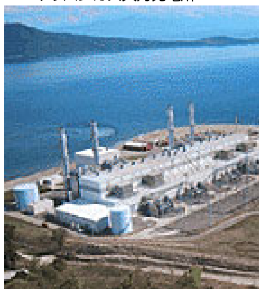
イリハンガス火力発電所
