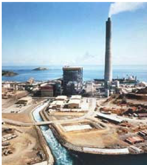
スアル石炭火力発電所
