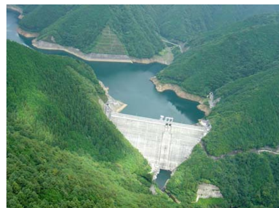
葛野川ダム全景
