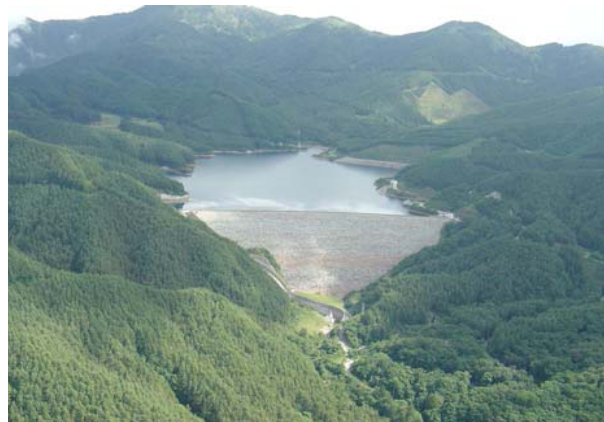
上日川ダム全景
