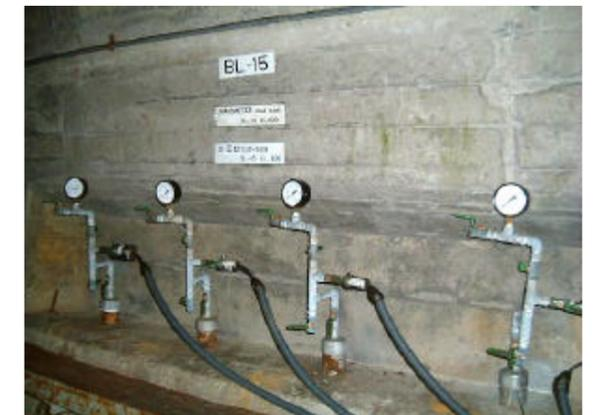
監査廊内のブルドン管式水圧計状況
