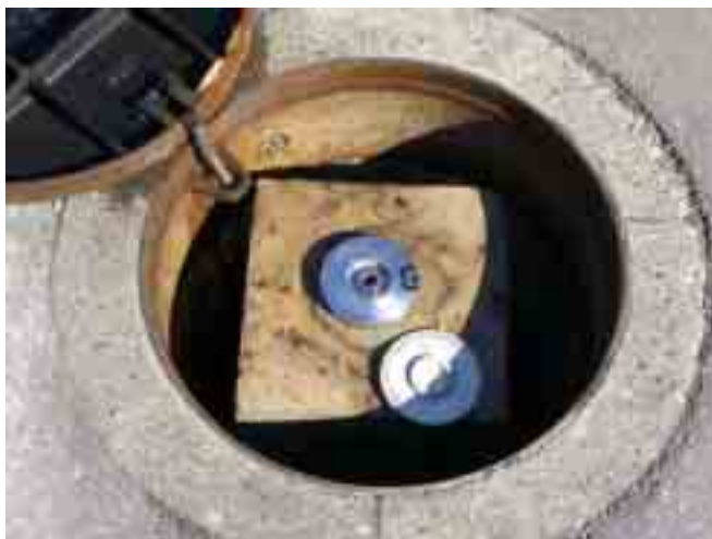
写真－3 No. 10 測定点状況（現在・近景）
