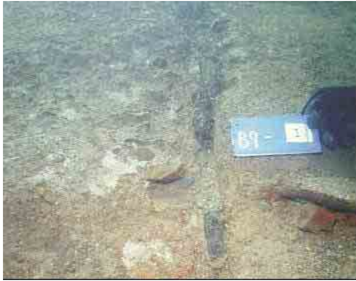
写真-13 表面遮水壁ジョイント周辺状況 (水中部：B9ブロック)
