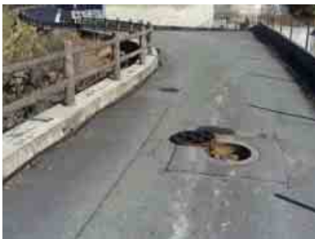
写真－2 No. 10 測定点状況（現在・遠景）
