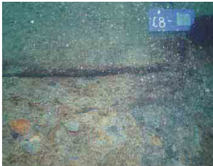
写真-14 表面遮水壁ジョイント周辺状況 (水中部：C8ブロック)
