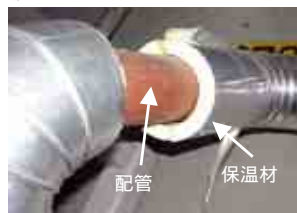
格納容器内の配管と保温材(例)
