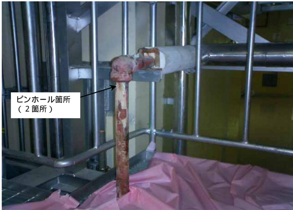
K-1 主蒸気リード管ドレン配管状況概略図
