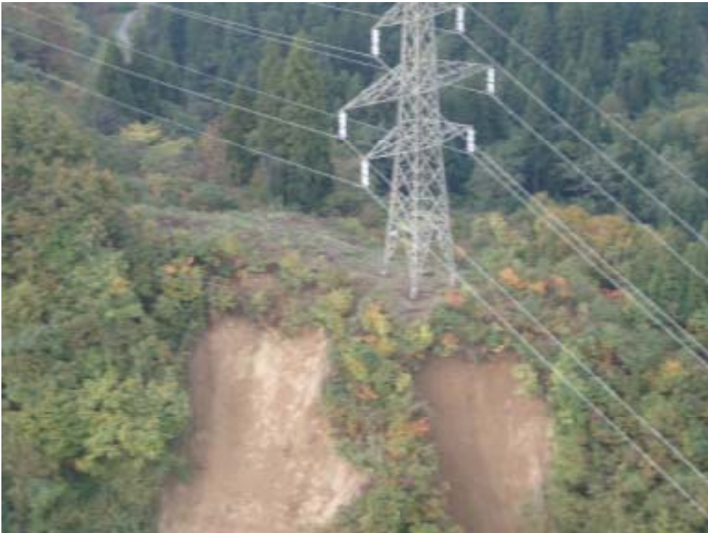
基礎部分近辺の崩落の状況
