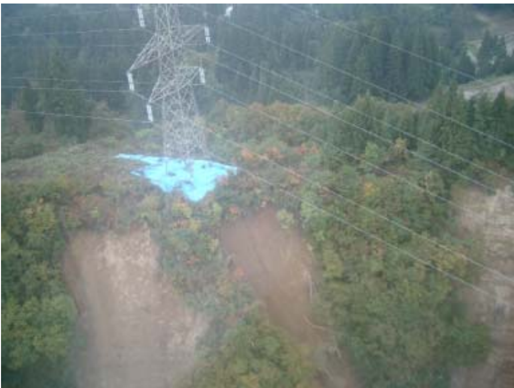
シート養生による降雨対策実施状況
