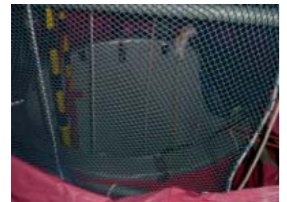
マンホールの養生 (図中、1F2の例)
