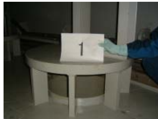
ベント管開口部 (図中、KK1の例)
