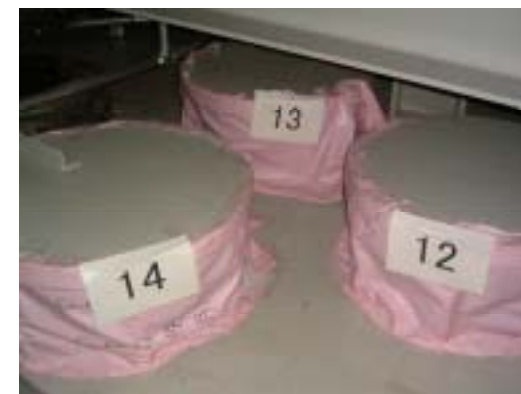
ベント管開口部の養生 (KK1の例)
